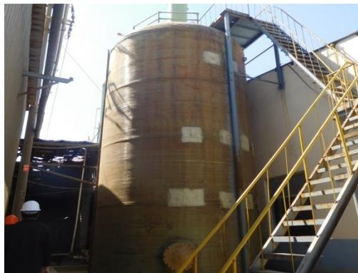
硫酸雾吸收塔（工业硫酸铝生产线）
