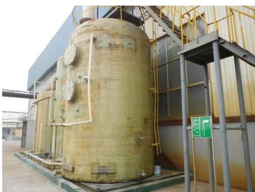
硫酸雾吸收塔（无铁硫酸铝生产线）
