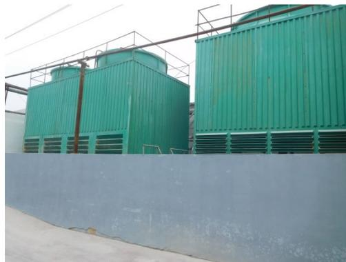
冷却塔+隔声板
